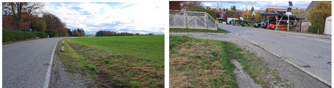
Abb. 4 Ortseingang Schondorf im Bereich der Landsberger Straße (Einmündung Bergstraße), Blickrichtung ortsauswärts (links) und ortseinwärts, Stand 07.11.2023
